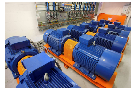
BANCS DE CHARGE PUISSANT POUR LES TESTS
